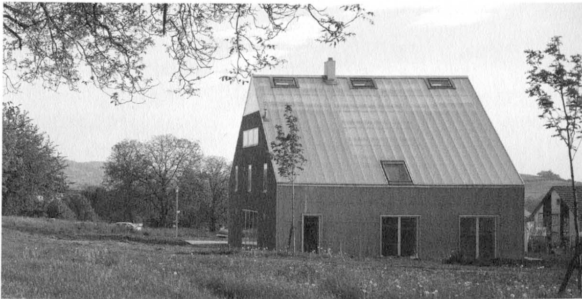
Abb. 2 – Patchworkhaus in Müllheim. Die Dachflächen und Seitenwänden bilden einen komplexen Luftkollektor mit transparenten Polycarbonatplatten, die eine kontrollierte Luftschicht bilden und zusammen mit den Speichermassen der Holzwände die Grundversorgung des Hauses mit passiver, solarer Energie sichern.
