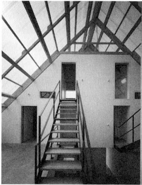
Abb. 4 – Patchworkhaus Müllheim. Auf künstliche Dämmstoffe wird verzichtet. Die im Dachspitz gesammelte Wärme wird über den zweiten Kaminzug mittels eines kleinen Lüfters zur weiteren Verteilung in die erdgeschossige Halle befördert. In den betonierten Geschossdecken ist eine Bauteilaktivierung integriert.
