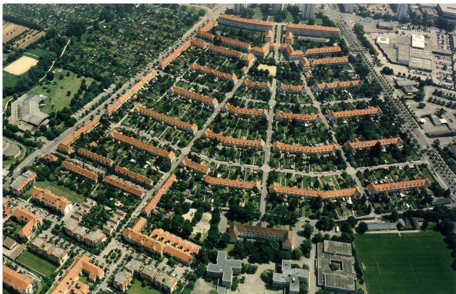
Die Gartenstadt Haslach blieb in allen Teilen – Haustypen sowie Straßenführung und -profile – erhalten und steht unter Denkmalschutz. Die energetische Modernisierung erfolgt ohne Dämmung
